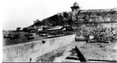
Castelo de Muros. Muro e torreta
