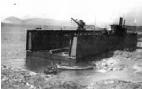
Dique Lagos Dock
