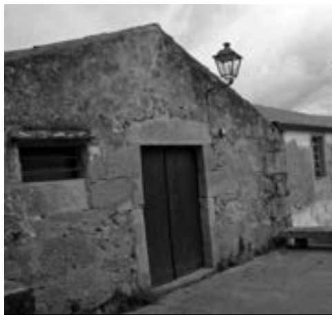
Muros. Casa terrea
