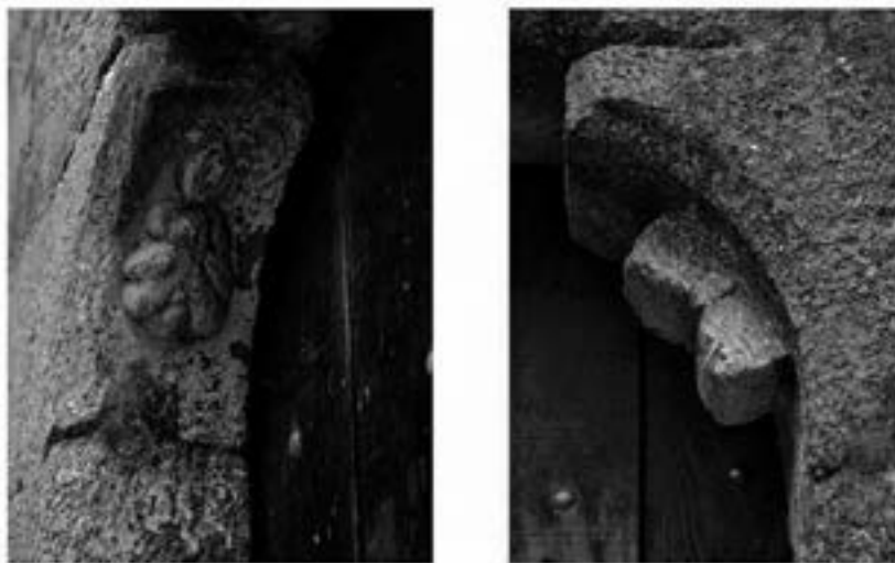
Porta principal. Detalle. O lintel que cobre o oco de acceso pousa sobre ménsulas labradas que representan a cuncha de vieira e o libro dos Evanxeos
