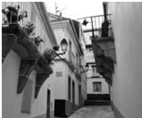
Muros. Casas con corredor
