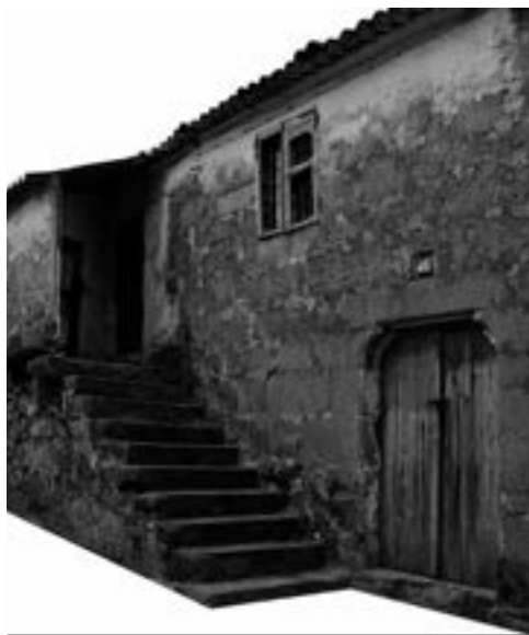
Inmable situado na travesa da rúa da feira co antigo camiño real, actual rúa Rafael Calleja, que se identifica como unha arquitectura da Idade Moderna: hospitaliño, casa de acollida ou albergaría. Na porta principal da fachada exhibe símbolos que aluden ao fenómeno xacobeo e á hospitalidade
