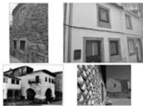
Os muros en cachotería estaban pensados para ser revocados en branco deixando en resalte as boas pezas en cantería. Os muros máis expostos protexíanse de diferentes maneiras
