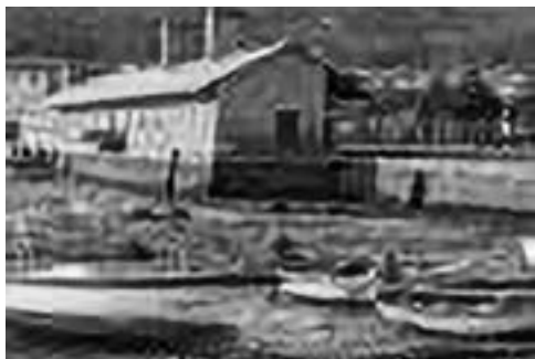
Muíño de Mareas do Pozo de Cachón. Serres. Muros
