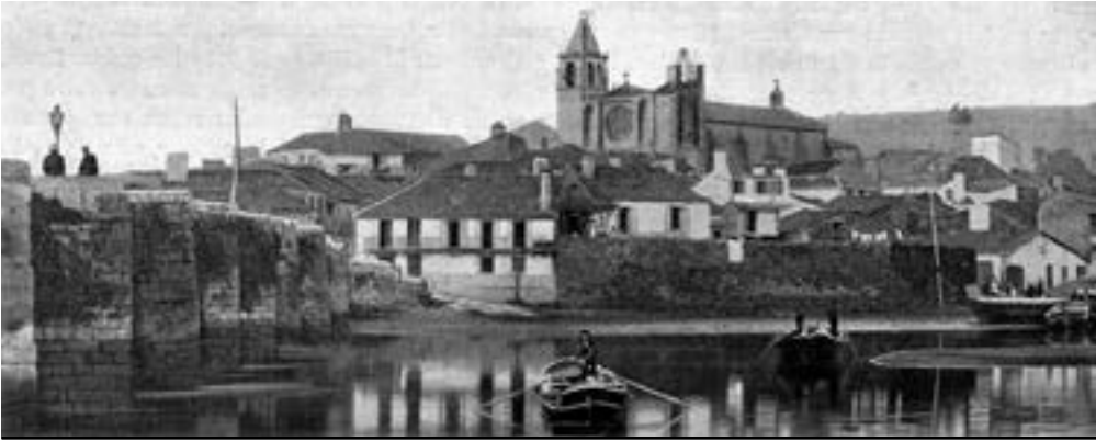
Noia. Rampla na ponte e porto do Puxilgo
