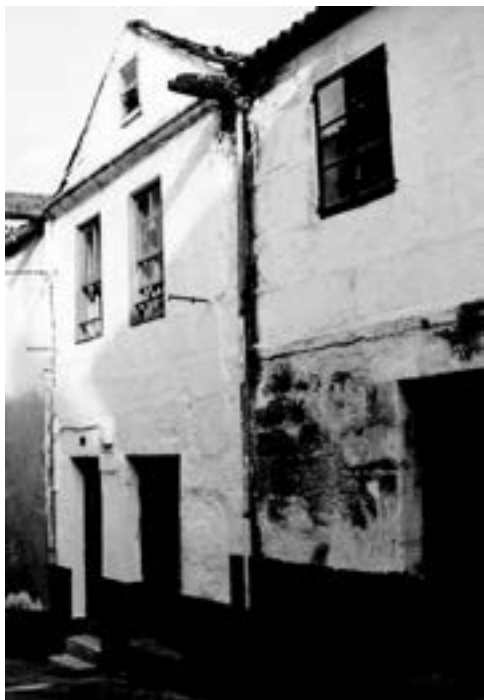
Muros. Casa do pincho de dous andares
