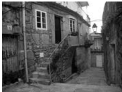
Muros. Casa con patín
