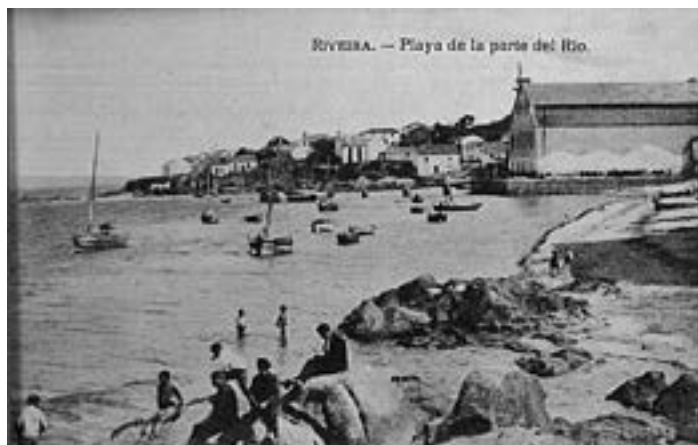
Fábrica de conservas de Silverio Pereira. Construída cara a 1860 como almacén de salgadura. Reconverteuse en conserveira cara a 1890
